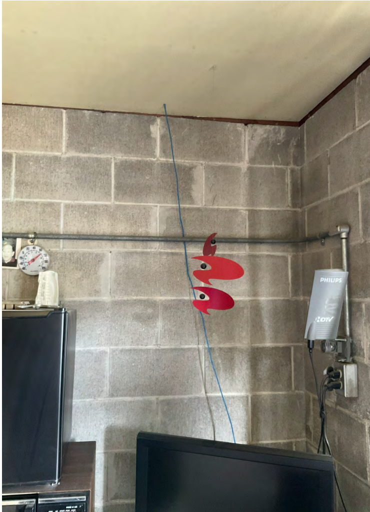
Existing Category 5e Cable.
